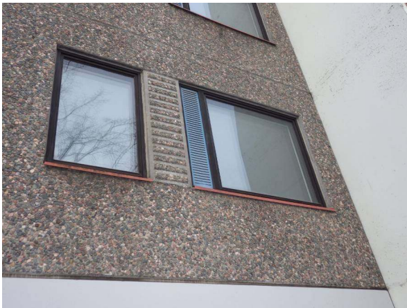
7. Ulkoseinät ovat pesubetonipintaisia.
