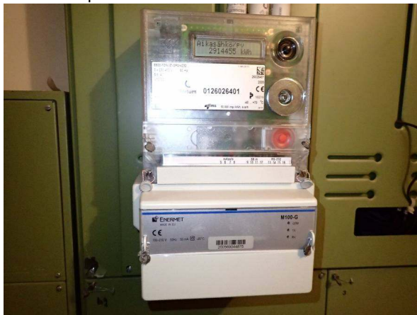
47. Sähköenergian mittari.
