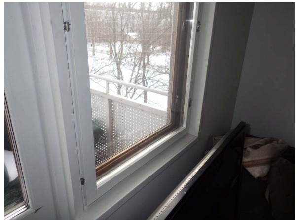
12. Uusituissa ikkunoissa ei havaittu merkittäviä vaurioita.
