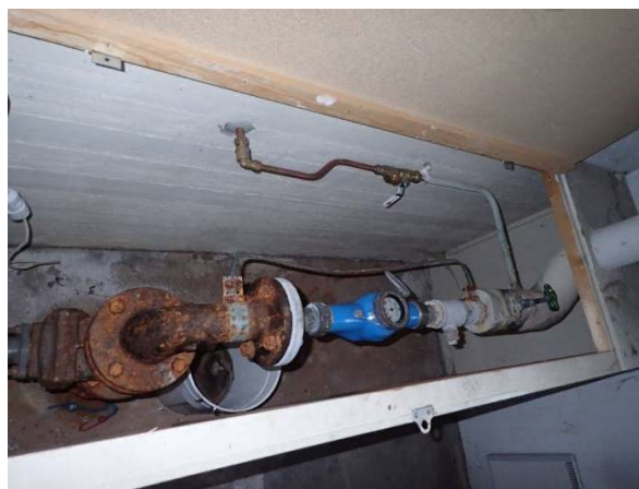
27. Kiinteistön päävesimittari.
