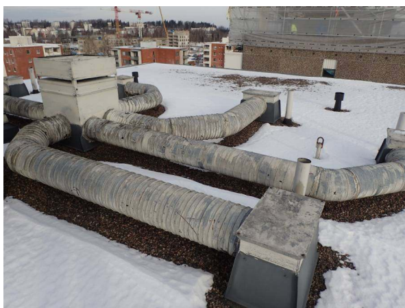
36. Huippuimuri ja kanavistoa katolla.
