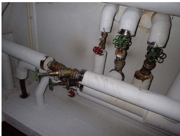
28. Käyttövesijohtoja kellarissa.
