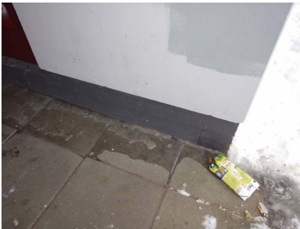
6. Perustuksissa ei havaittu korjausta vaativia vaurioita.
