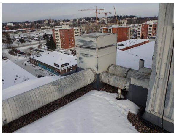
37. Huippuimuri ja kanavistoa katolla.
