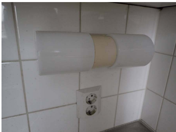
58. Keittiötilan alkuperäinen valaisin.
