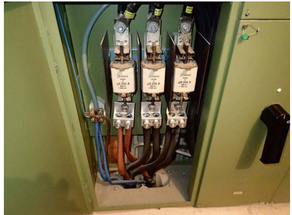
46. Sähköpääkeskuksen pääsulakkeet.
